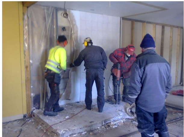
Kuva 4. Kokoustilan kylpyhuoneen purkaa
