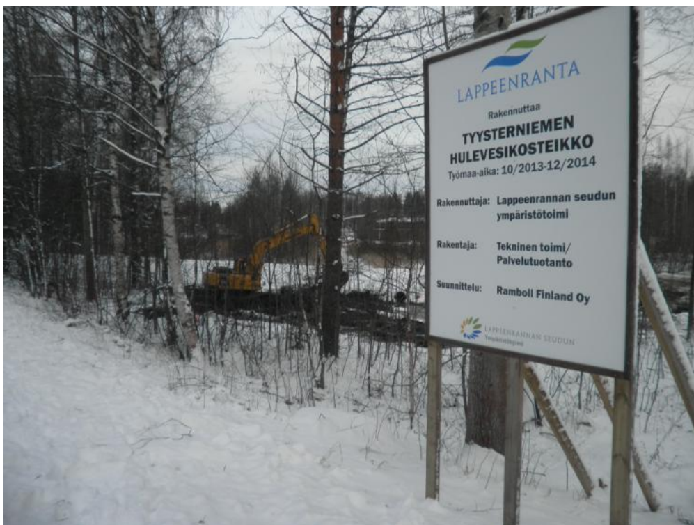
Tyysterniemen hulevesikosteikon työmaa 4.12.2013
