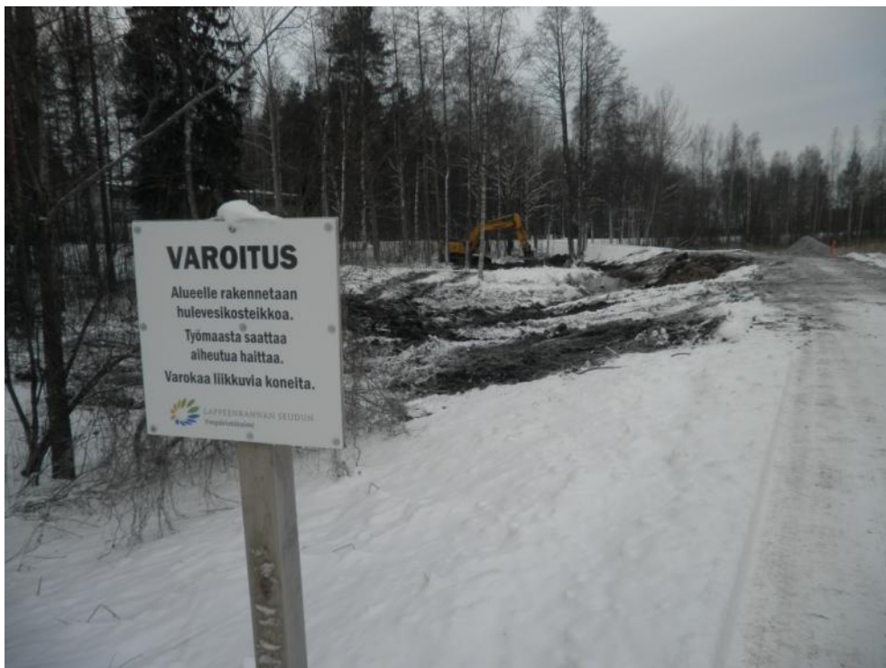
Tyysterniemen hulevesikosteikon työmaa 4.12.2013
