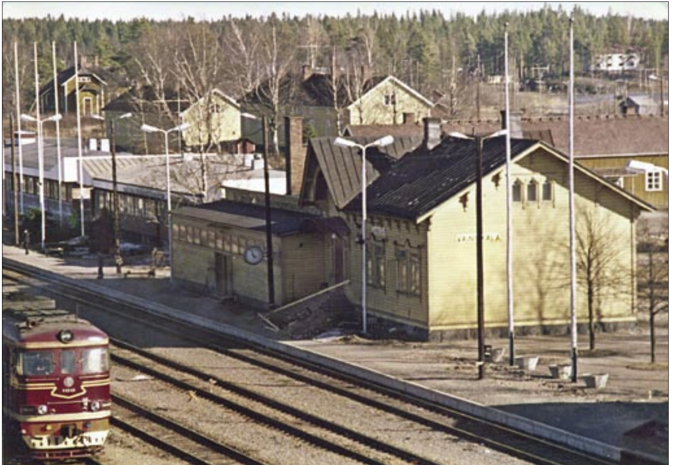
Vainikkalassa on ollut joskus kaksi rautatieasemaa. Etualalla purkutyön alla oleva vanha ja taustalla matala tiilinen uusi asemarakennus vuonna 1970. Mutta moniko tietää, mikä rakennus siintää ylhäällä vasemmalla? Takakannen kuva onkin sitten tavallaan jäähyväiset Vainikkalan kaupalle. Kuvassa aurinkoinen Vainikkalan Yhtymä vuonna 1973, kun kaikki oli vielä kunnossa. (kuvat Antero Pohjonen)
